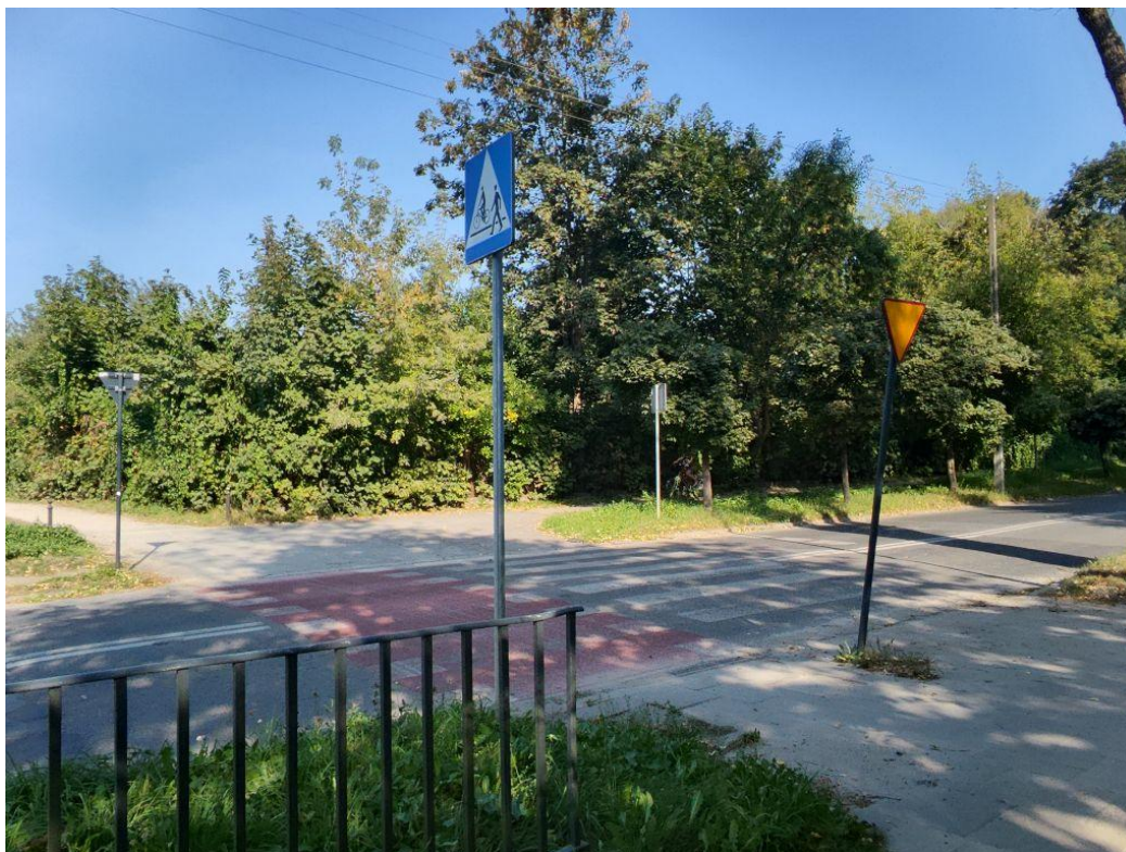
Fot. 28 Poprawne oznakowanie izolowanego przejazdu dla rowerów. /Michał Rejczak/
