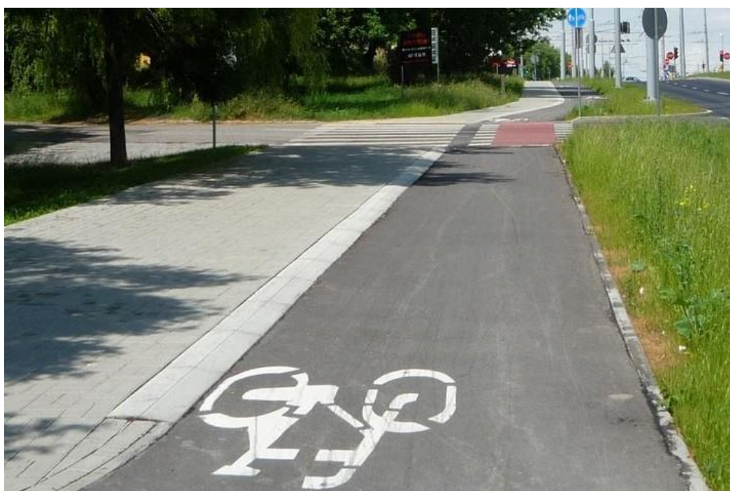
Fot. 11 Oddzielenie drogi rowerowej od chodnika za pomocą leżącego krawężnika. /Michał Rejczak/
