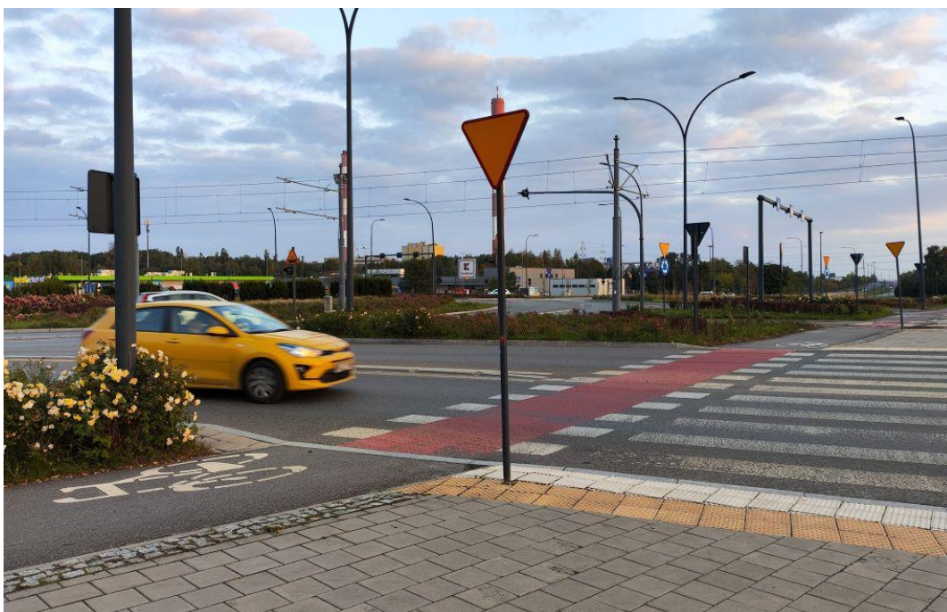
Fot. 29 Oznakowanie przejazdów rowerowych przez wloty ronda turbinowego. /Michał Rejczak/
