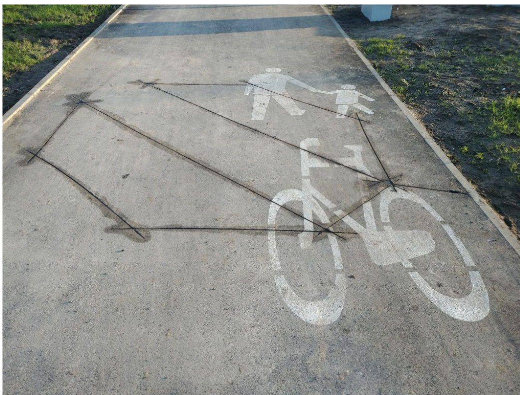
Fot. 30 Przykład detekcji automatycznej na drodze dla pieszych i rowerów za pomocą pętli. /Michał Rejczak/
