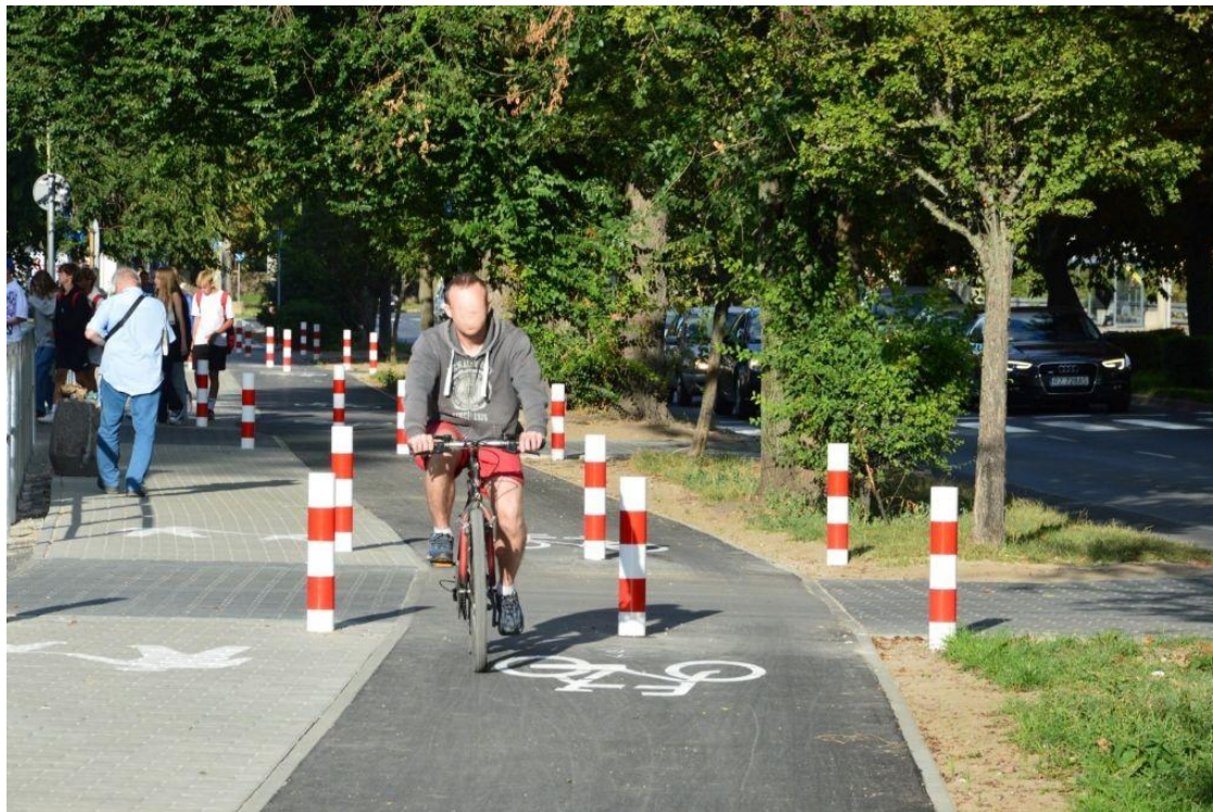
Fot. 33 Poprawna lokalizacja słupków zabezpieczających. Brak wymaganego oznakowania poziomego. /Michał Rejczak/
