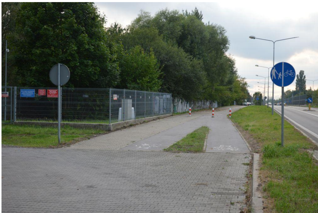
Fot. 25 Podłączenie drogi dla rowerów do jezdni serwisowej wraz z zabezpieczeniem wjazdu. /Michał Rejczak/
