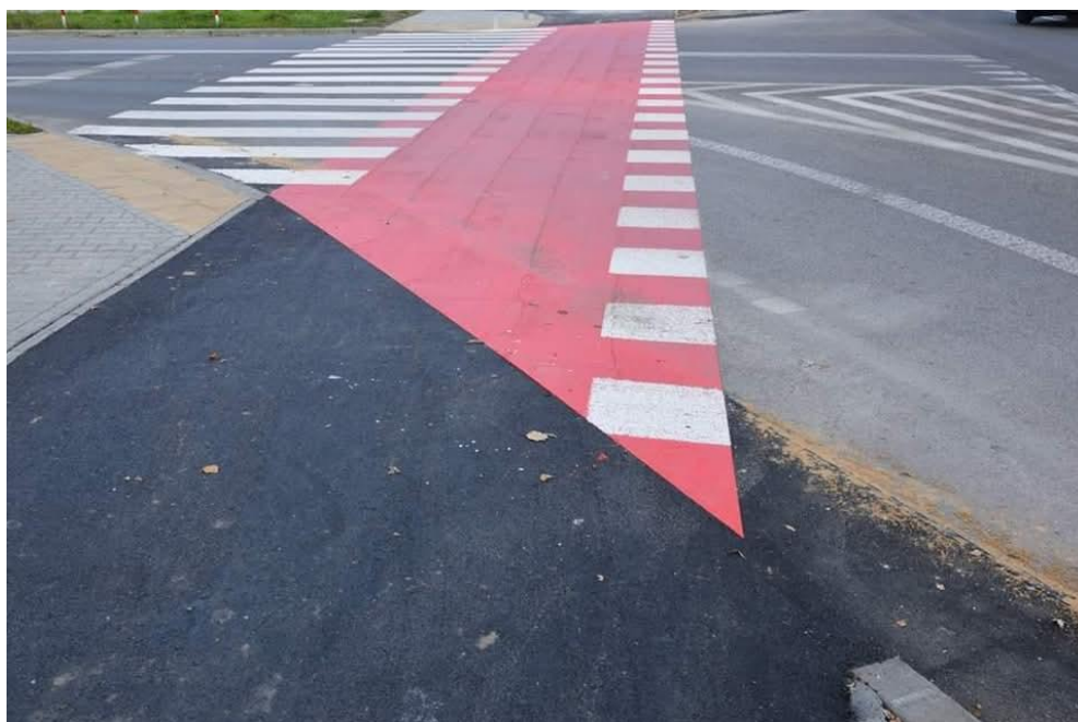
Fot. 10 Połączenie bezkrawężnikowe nawierzchni drogi dla rowerów na przejeździe dla rowerów. /Michał Rejczak/
