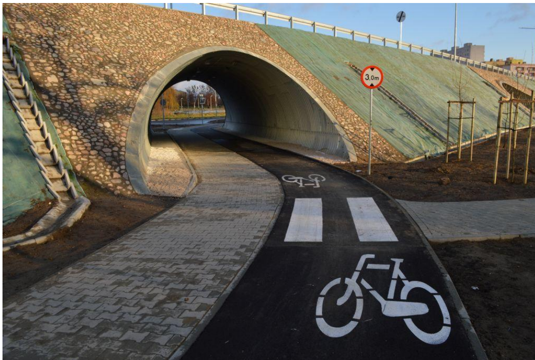
Fot. 34 Tunel dla pieszych i rowerów przez nasyp drogowy. /Michał Rejczak/
