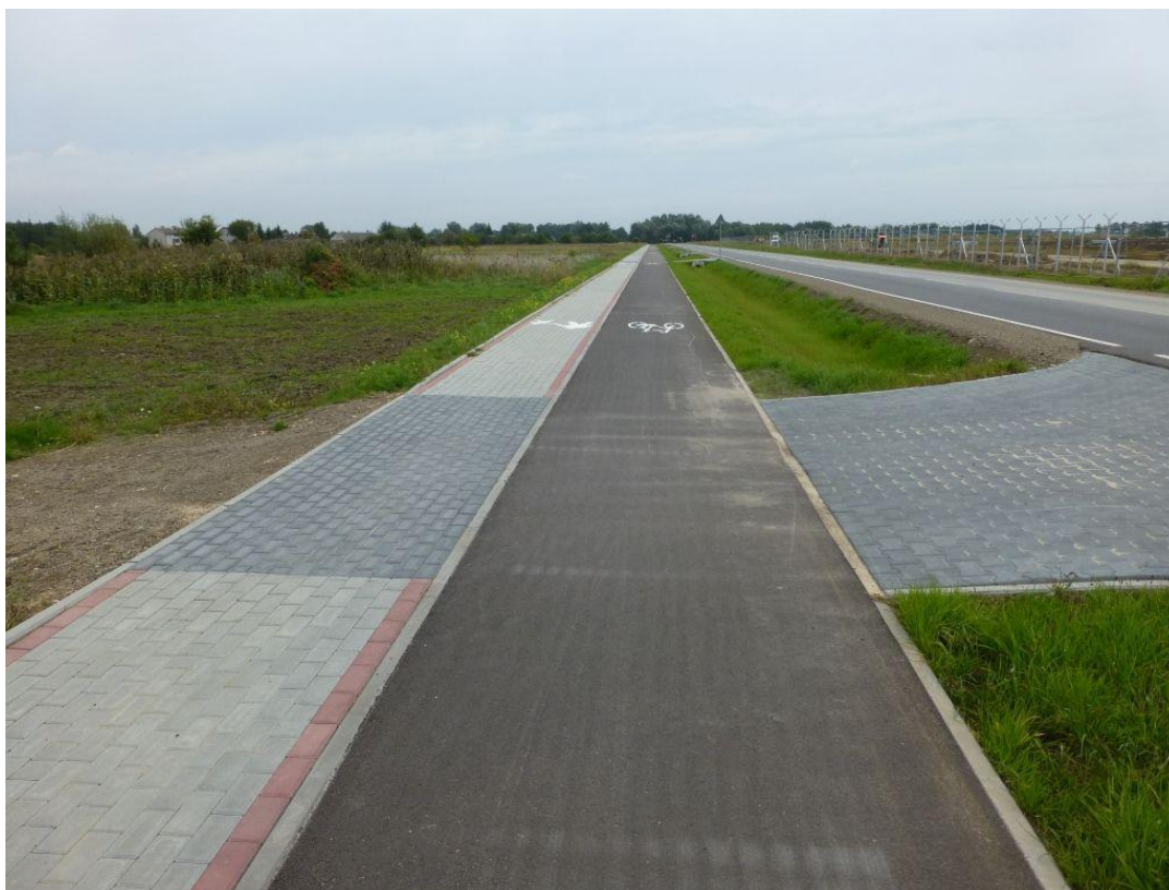
Fot. 8 Droga dla rowerów z utrzymaną ciągłością nawierzchni oraz niwelety w obrębie zjazdu. /Michał Rejczak/
