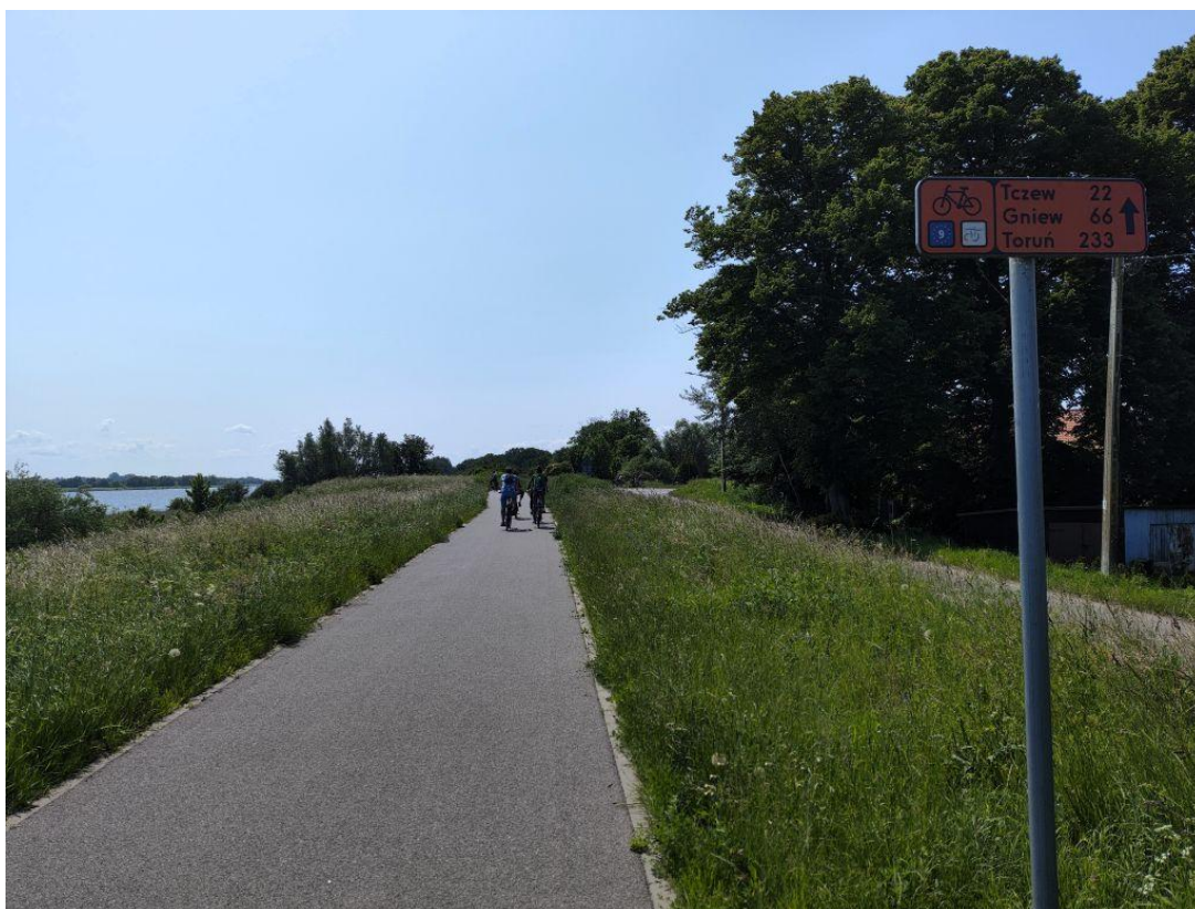
Fot. 20 Trasa prowadzona koroną wału przeciwpowodziowego. /Michał Rejczak/
