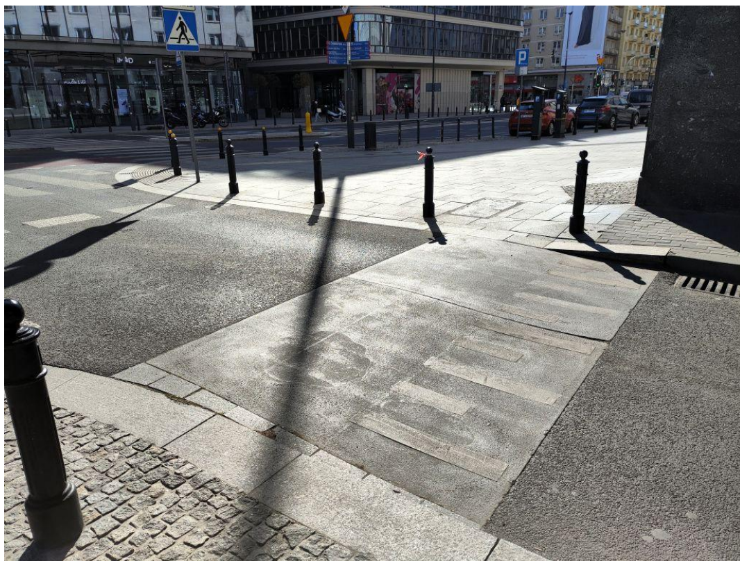
Fot. 15 Najazd sinusoidalny na próg płytowy. /Michał Rejczak/
