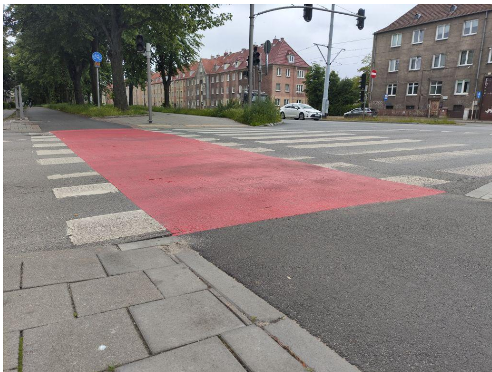
Fot. 4 Zwiększenie czytelności przejazdu dla rowerów poprzez czerwony kolor nawierzchni. /Michał Rejczak/
