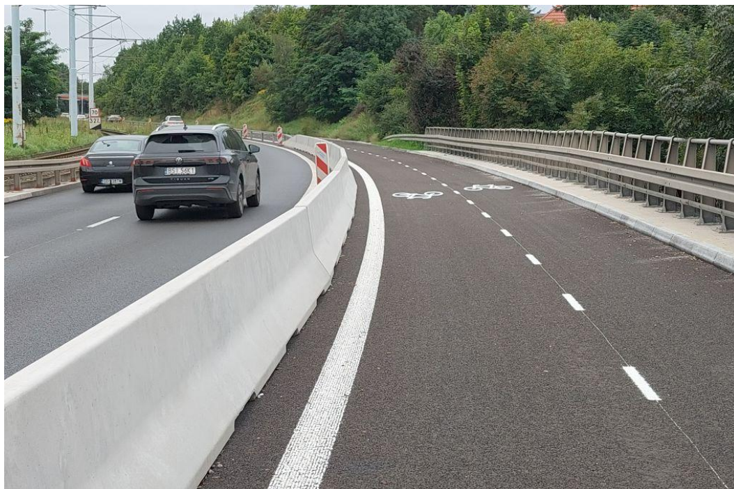
Fot. 31 Przykład wydzielania drogi rowerowej w istniejącym przekroju jezdni za pomocą barier U-14. /Roger Jackowski – Rowerowa Metropolia/
