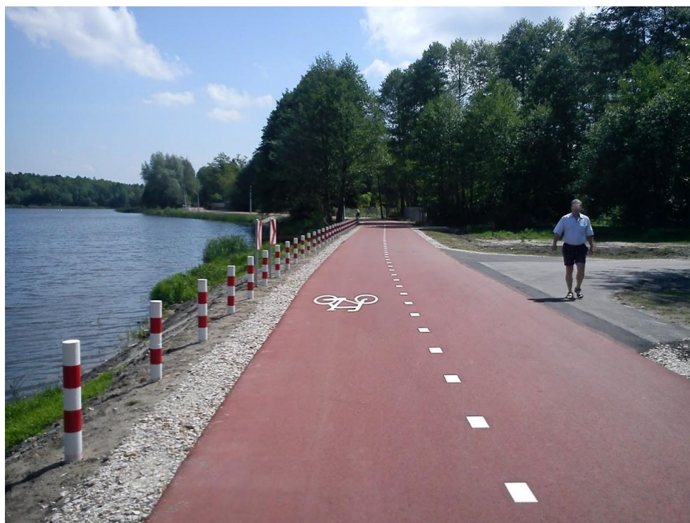
Fot. 5 Droga dla rowerów prowadzona brzegiem zbiornika wodnego i wśród zieleni. /Michał Rejczak/
